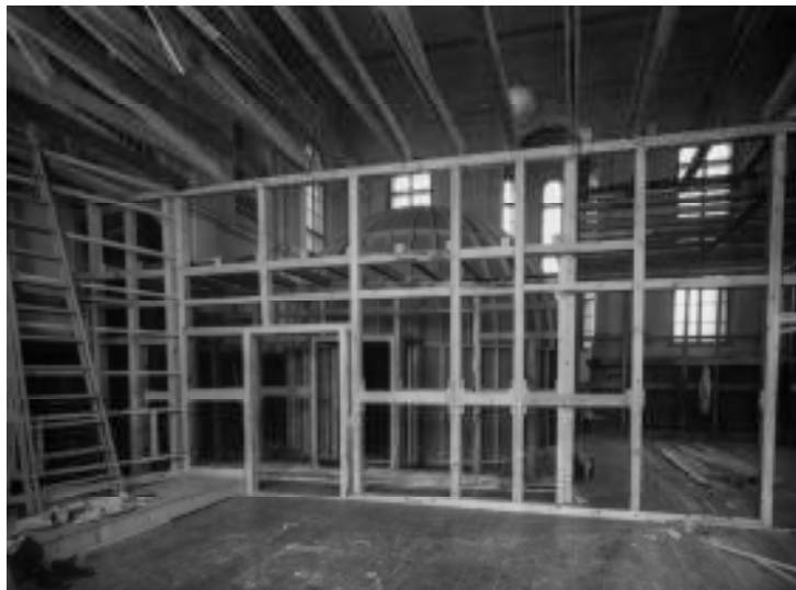
Budování kopule astrosálu (vlevo) pro planetárium ZKP 1 a výstavba přednáškového sálu (vpravo) v budově nad Hamburkem
