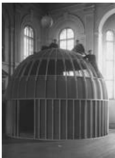
Budování kopule astrosálu (vlevo) pro planetárium ZKP 1 a výstavba přednáškového sálu (vpravo) v budově nad Hamburkem
