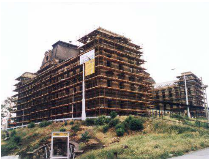
Budova nad Hamburkem v době těsně před rekonstrukcí
